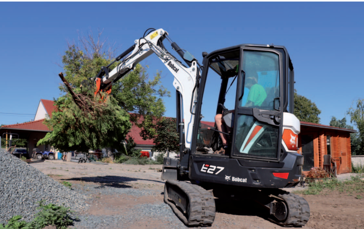
Obr.: Rýpadlo Bobcat E27 Jiřího Hložka. Hydraulický přidržovač nachází využití při manipulaci se dřevem.
